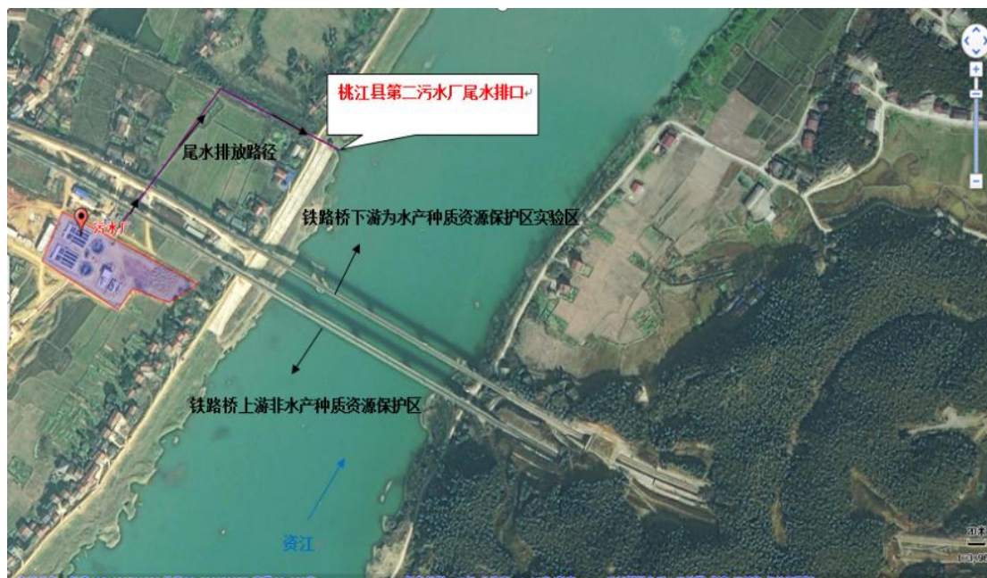
图 5.1-1 桃江县第二污水处理厂排污口位置
